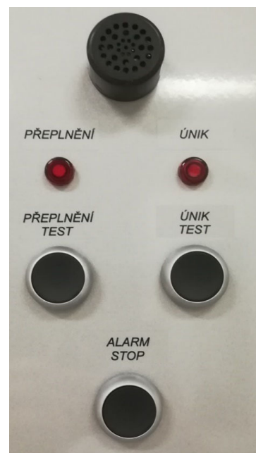
Obrázek 4 - Signalizační prvky přeplnění a úniku
